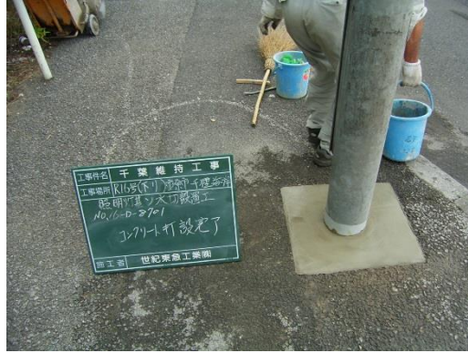
図-2. 2. 2 水切りコンクリートの施工事例
