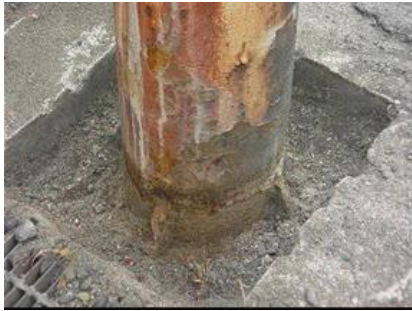
(柱脚部 (路面境界部) )
