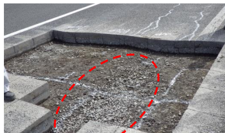
路盤の損傷の例 (路盤の細粒分がポッピングにより流失し、碎石が集まっている状況)
