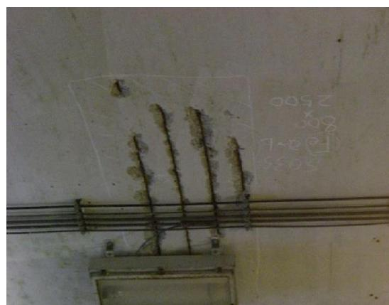
写真-2 鋼材腐食の例
