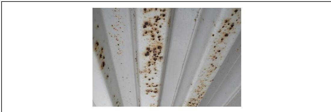
損傷の面積が大の例（着目部分の50%以上に錆が生じている又は局所的な錆が着目部分内に多数発生して結果として着目部分の範囲内で拡がっている例）
