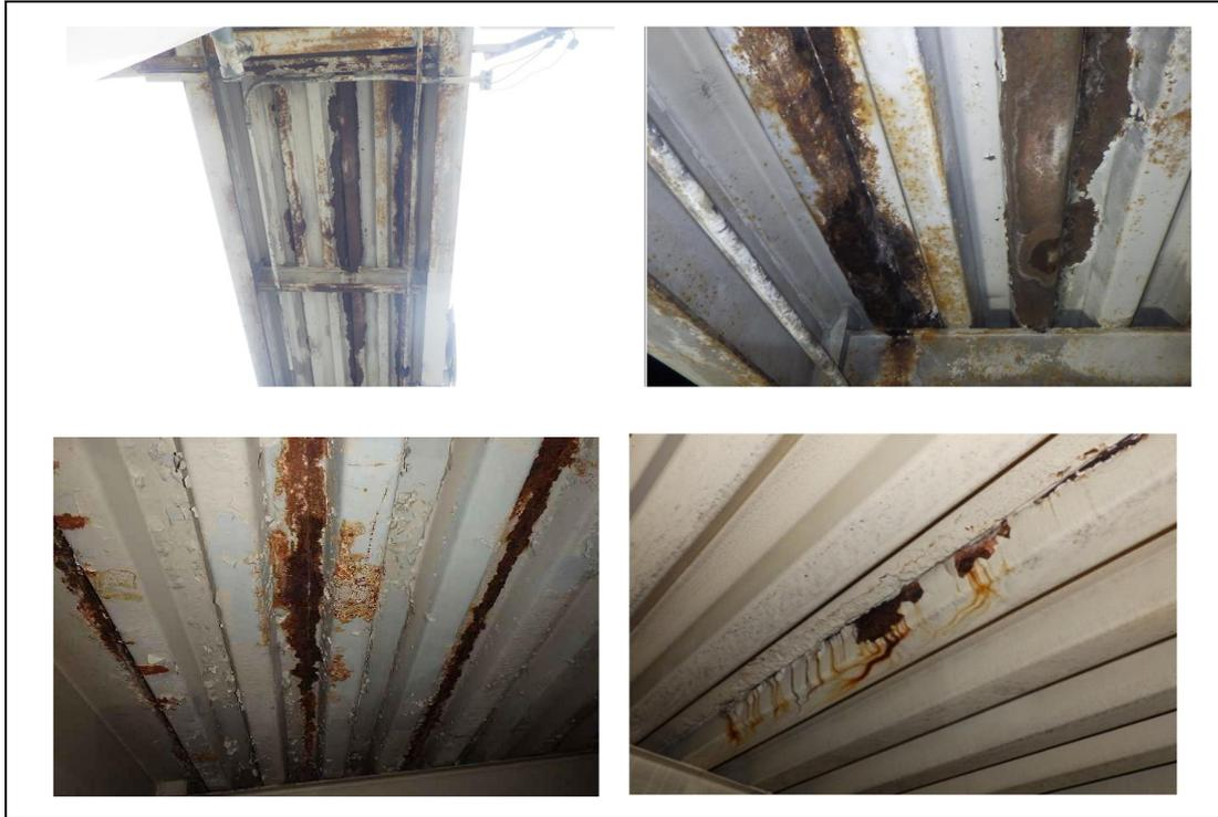
損傷の面積が大の例（拡がりのある発錆箇所が複数ある例）
