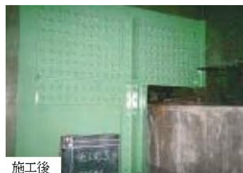
写真 3 当て板（鋼板）による補修の施工例（切欠き部）
