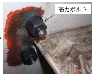
写真 19-3 当て板(鋼板)による補修の施工例(切欠き部)
